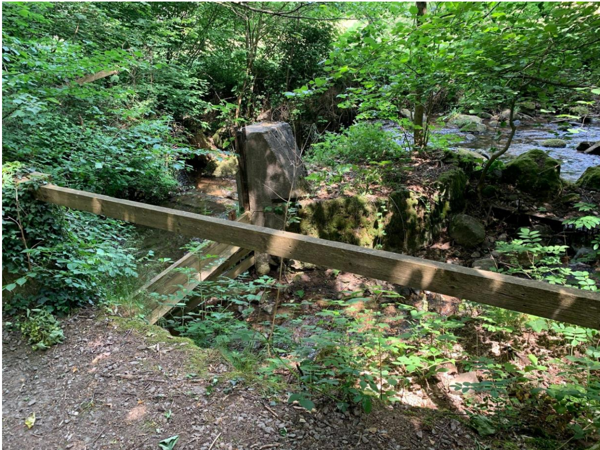
Abbildung 39: Station 11 Standort für Staudamm (Quelle: eigene Aufnahme)
